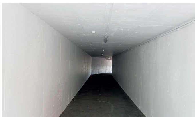
Kulvert til Fana Stadion under Grimseidvegen.
