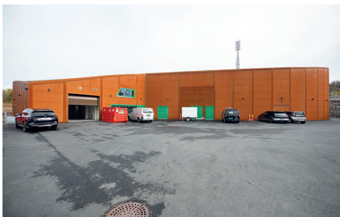
Asfaltert plass nordvest for bygget.
