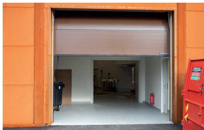
Port mot asfaltert plass.
